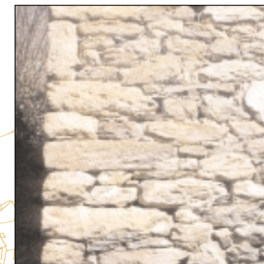
Appareillage en blocs de granit, Col du Sarraillé (à gauche), blocs de calcaire à Irazein (à droite)
