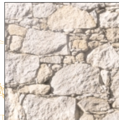
Appareillage en blocs de granit, Col du Sarraillé (à gauche), blocs de calcaire à Irazein (à droite)
