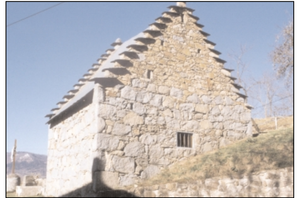
Grange au hameau du Tourn, Col du Sarraillé : maçonnerie de pierre calcaire et de granit
