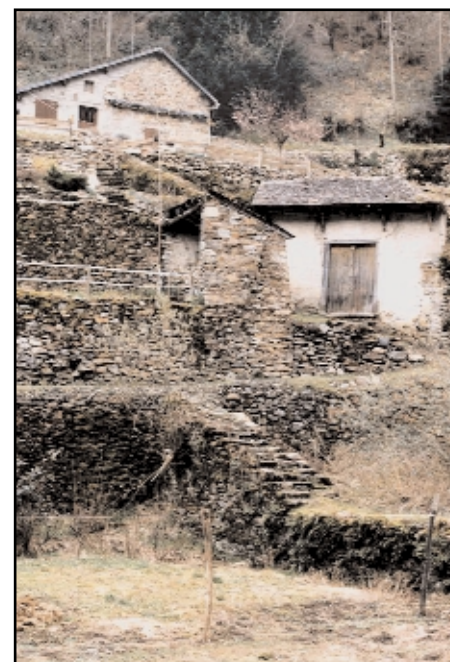
Murs de soutènement et escaliers à Couffens
