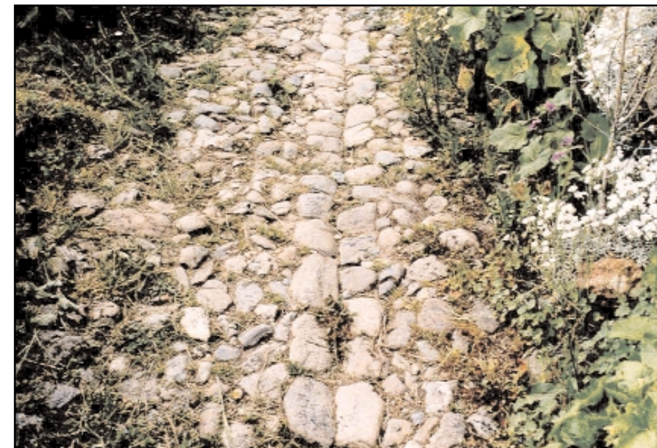
Ruelle pavée avec caniveau central
