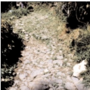
Pavage d'une ruelle avec des pierres locales, Salsein à gauche, Arrout à droite.
