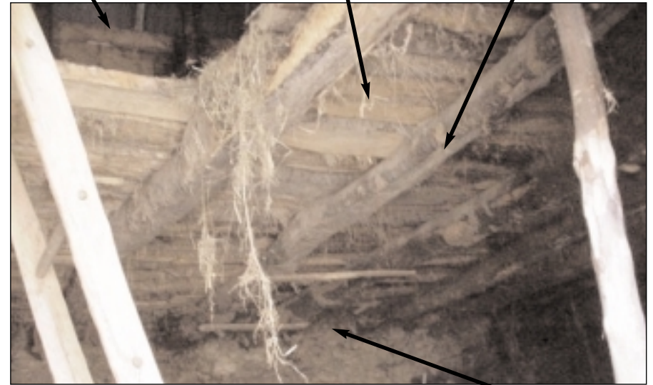
Vue sur le plancher du fenil d'une grange
