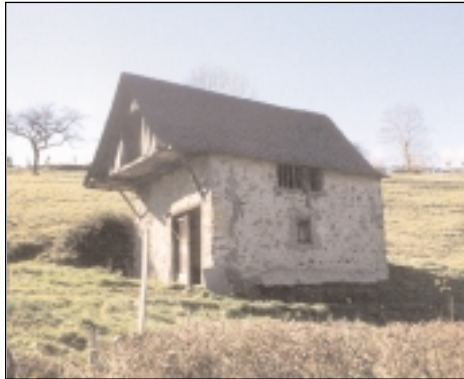
Le plancher avançant sur le pignon permet d'augmenter le volume du fenil et de créer un abri au rez-de-chaussée.
