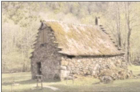
Saurat, toiture en chaume
