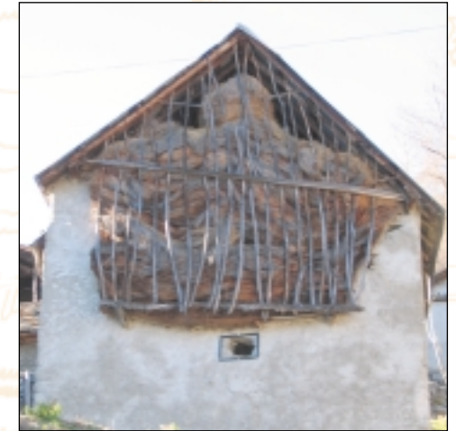
Bardage vertical en planches de bois, à droite, clayonnage de branches de noisetier, à Lapège
