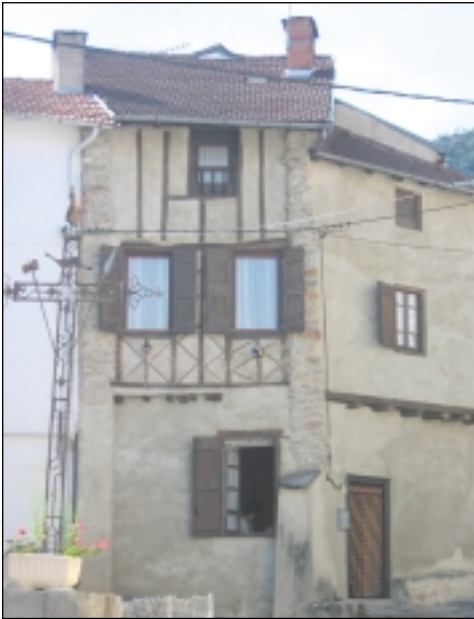
Banat, ossature à pans de bois sur la partie fenil de la grange, protégée par l'avancée du toit
