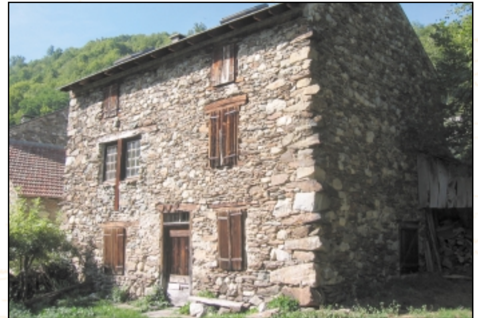
Maison d'habitation à Rabat : maçonnerie de pierre calcaire et de gneiss
