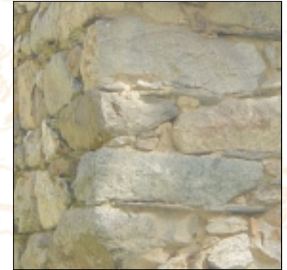
Appareillage en blocs de calcaire à Montailou (à gauche), blocs de gneiss à Orus (à droite)
